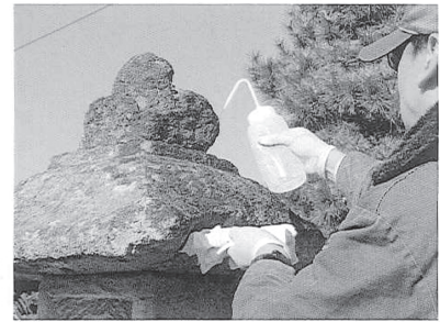
③表面を強化する薬剤を浸み込ませる。
