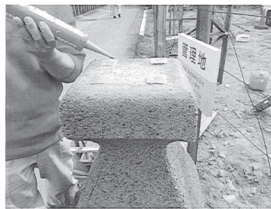
⑦免震材を入れる。
