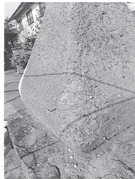
④欠けた部分にモルタルを埋めた後、表面を擬石 ぎせき 加工する。
