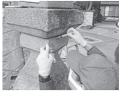
②ひび割れに樹脂を注入する。
