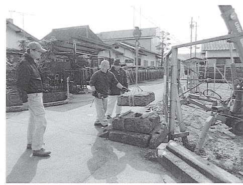
⑤クレーンで燈籠を解体する。
