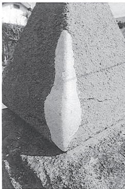
④欠けた部分にモルタルを埋めた後、表面を擬石 ぎせき 加工する。
