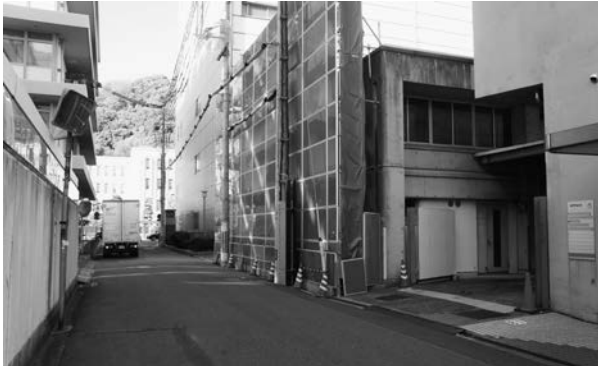
《2階建て駐輪場の解体準備》
