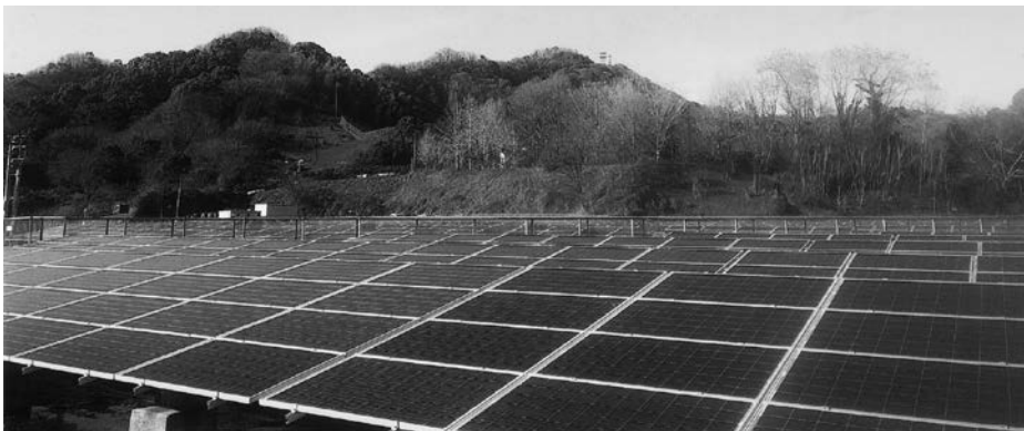
《メガソーラー発電所》
